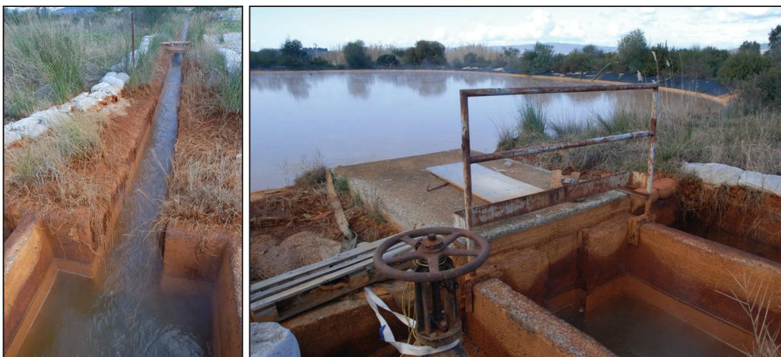
Figura 2.14 - Canale di afflusso al bacino di decantazione di S. Giovanni, attuale sistema di trattamento dei drenaggi di miniera di Gavorrano.
